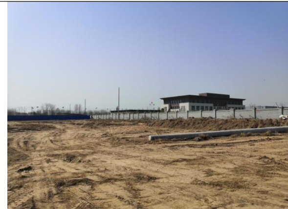
110kV 箕城变电站西侧现状
