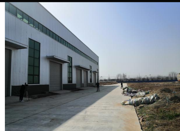
110kV 箕城变电站东侧现状
